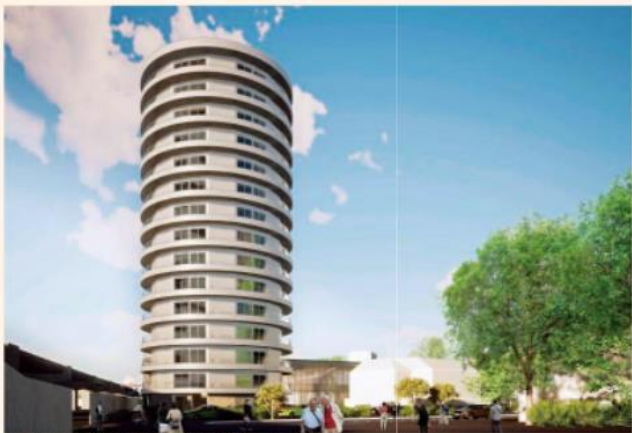
■總高15層樓的東洋木町用木材打造，為了提升防震能力，設計成獨特的圓形結構。
